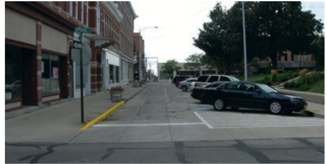
Foto 14 - A Av. Court, em Bellefontaine – Ohio/EUA é reconhecido por ser a primeira rua de concreto pavimentada no país.
