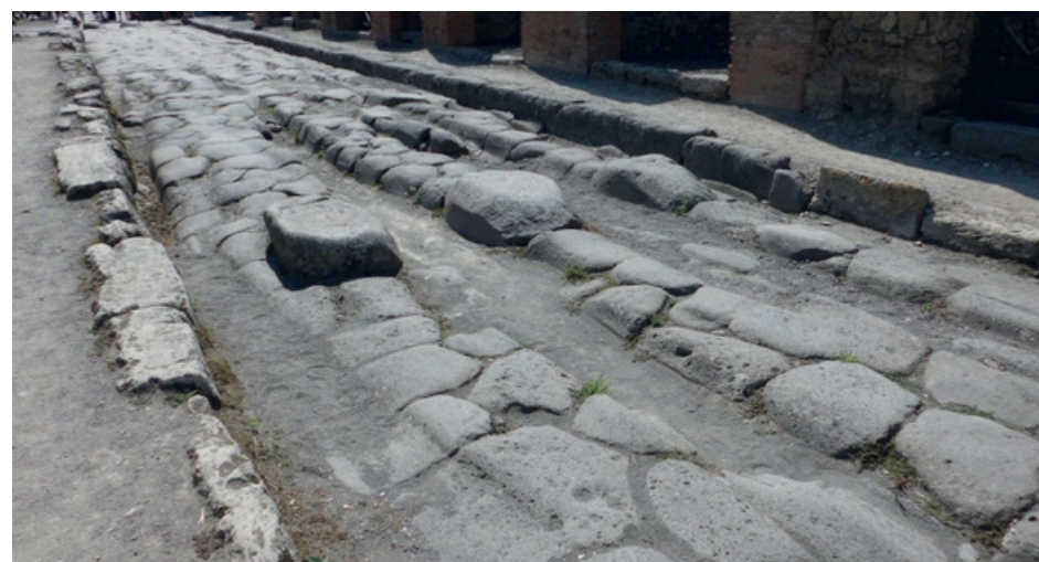
Foto 4 - A comunicação era muito importante para manter o Império. As estradas tinham que ser bem conservadas, com regras de uso e tráfego disciplinado. Em função do grande tráfego de uso, os pavimentos tinham tendência de criar trilhos, pelo desgaste com a passagem das rodas de carroças e bigas que garantiam a logística, a segurança e comércio entre as regiões.
