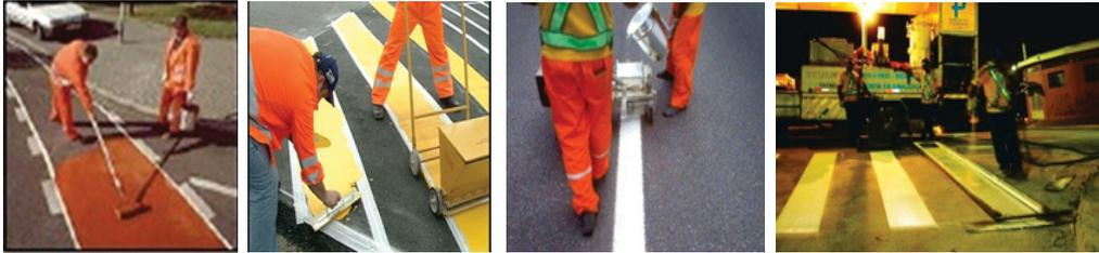
**Manualmente** pode ser aplicado com rolo, espátula, sapata de arrasto, pequenos equipamentos autopropelidos ou não (conhecidos por Plastomarkers) e equipamentos hidráulicos “air less” de aspersão. É necessário um gerador de energia elétrica, uma furadeira elétrica e uma haste homogenizadora.
